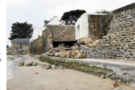
Le mur d'une propriété proche face à la mer entre la plage de la Neugier et la plage de Larmor Plage.
