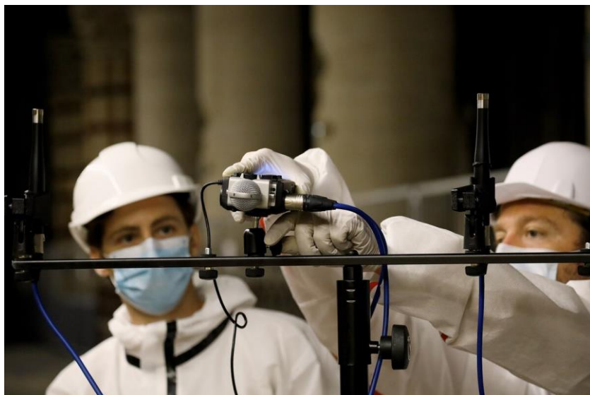
Installation du matériel de captation pour un relevé acoustique, chantier de Notre-Dame de Paris, 2020.
